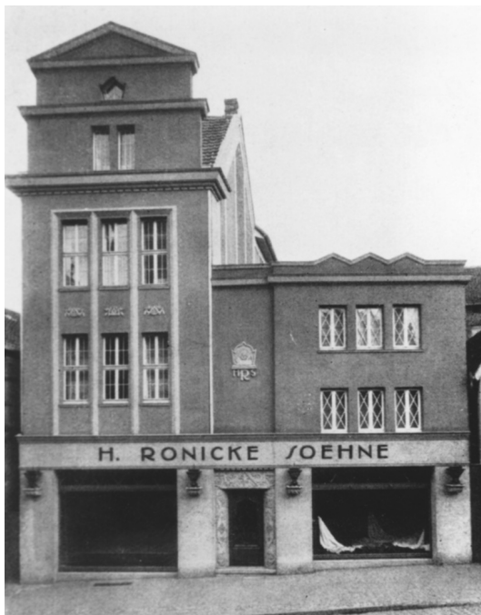
Stammsitz des Möbelhauses Ronicke an der Hufschmiede 17/19 nach der 1924 erfolgten Umgestaltung der Fassade. Das Gebäude wurde 1989 abgebrochen.
