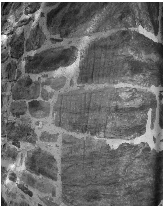
Steinscharten im Portasandstein an der Südwestecke der Dorkapelle in Barkhausen.
