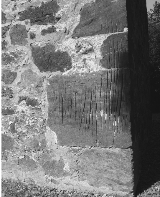
Steinscharten im Portasandstein an der Südostecke der Dorfkapelle in Barkhausen.
